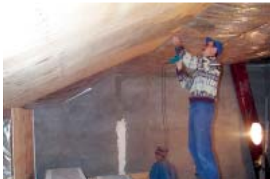
Отделочные работы на мансарде
