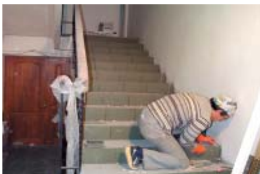
Облицовка лестничного марша
